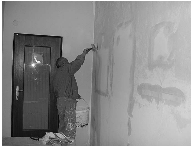
Die Ausmalarbeiten haben begonnen
