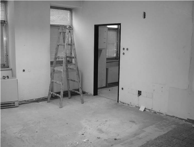
Der Jugendraum vor den Arbeiten
